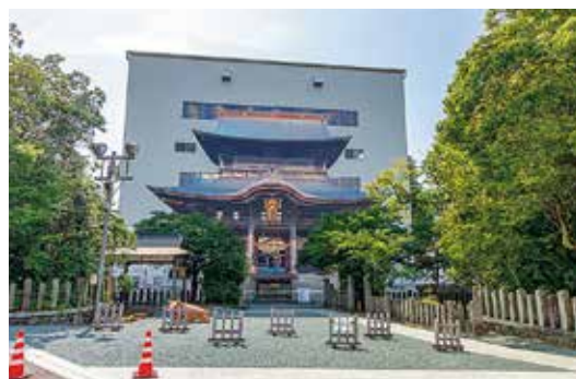
(アフター) 現在修復中の楼門
